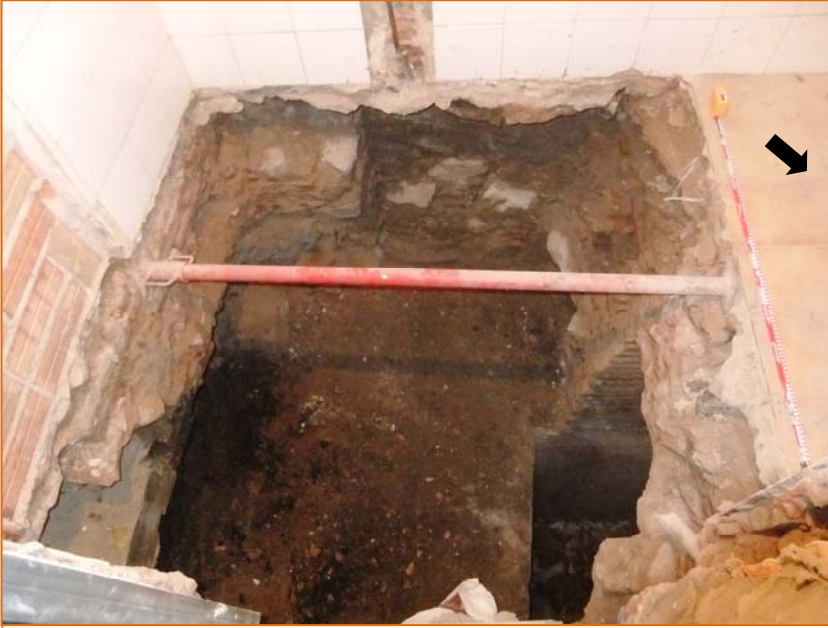
Foto 15. Fotografia final intervenció.
