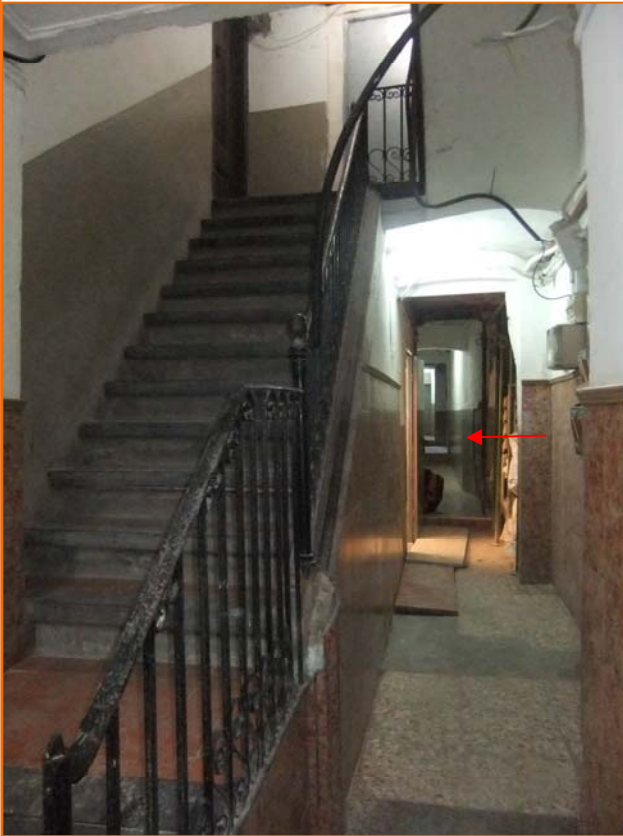
Foto 1. Ubicació de la intervenció.
