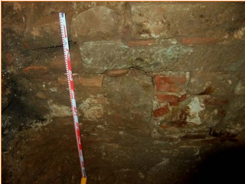
Foto 12. Detall de la fonamentació UE 018.
