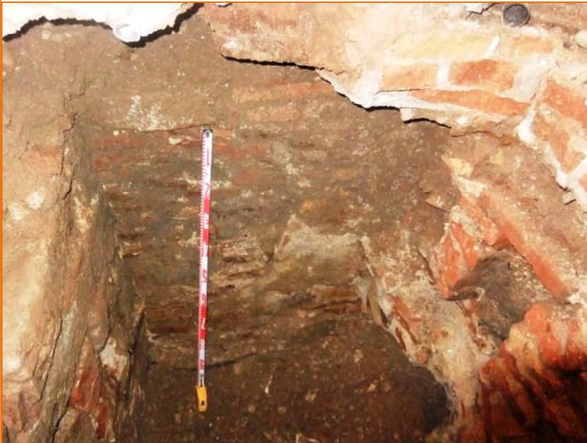
Foto 13. Detall de la fonamentació UE 019.
