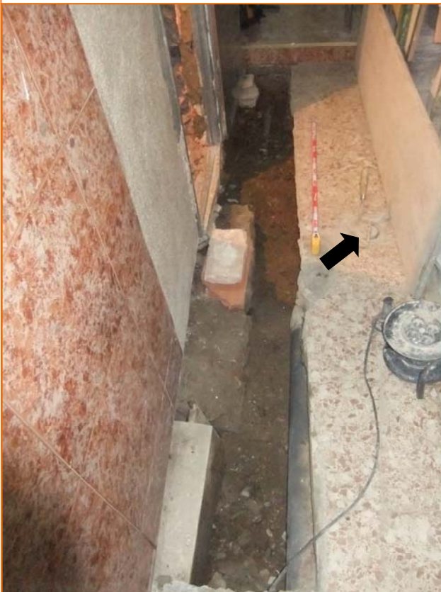
Foto 14. Rasa per reconduir el servei d'aigua residual.
